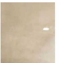
Enduit chaux, terre, chanvre
